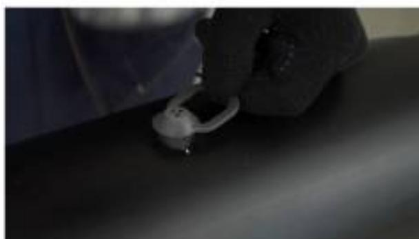
**7. После затвердевания ППУ, удалить пробку для стравливания воздуха и установить коническую пробку, запаяв её при помощи специального инструмента.**
